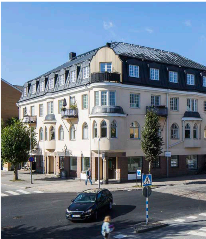
Holmström Fastigheter: Postmästaren 2, Nynäshamn.
