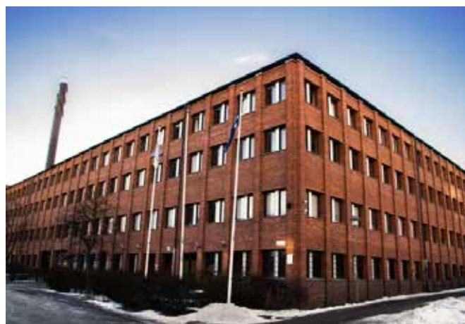
Vincero Fastigheters fastighet på Instrumentvägen 29-31 i Stockholm består av kontor och lagerlokaler.
